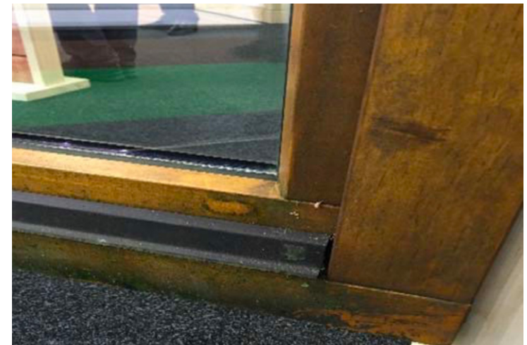
Keine Verschlechterung der Beschichtung sichtbar
